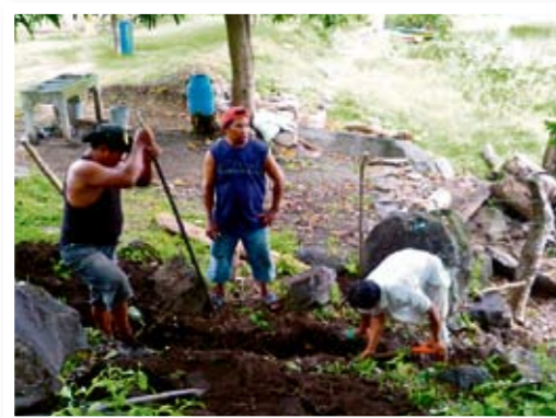
La comunità partecipa attivamente con la manodopera per i lavori di base
