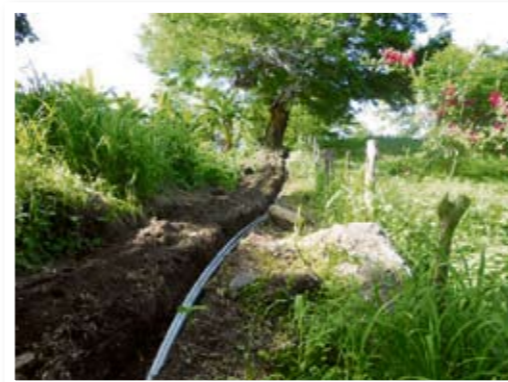
Sono stati posati 1 km di tubi
