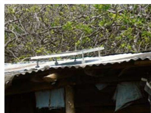
Un piccolo pannello solare risponde alle necessità minime
