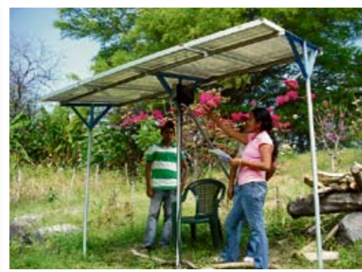
I pannelli solari che alimentano la pompa
